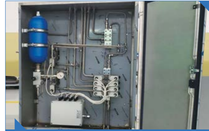
HİDROLİK VALF ÜNİTESİ (HYDRAULIC VALVE UNIT)
